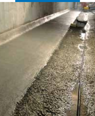
Mapefinish HD po vyhlazení
