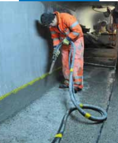
Strojní aplikace Mapefinish HD
