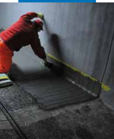
Vyhlazování Mapefinish HD ocelovým hladítkem
